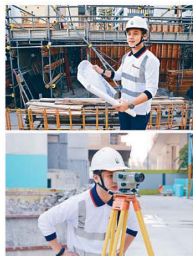
●監工負責管理並監督工地的工程，期間亦需不同工具輔助。
