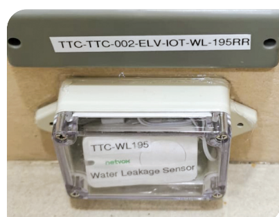
漏水傳感器(點型)
