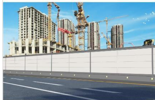
A2：装配式H型钢结构围蔽 适用范围 一般地区道路 景区改造 景区围挡 结构体系 装配式轻钢结构、预制混凝土基础 通用工程 适用于中、小型工程项目
