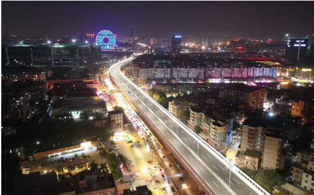
芳村大道南快速路改造
