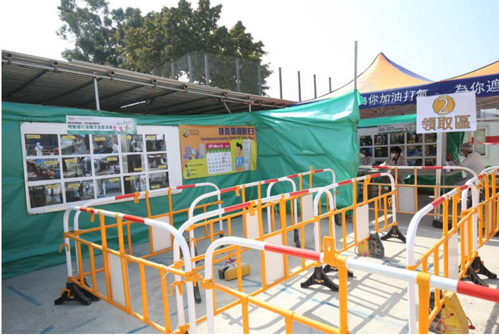
位於沐泰街的啟德體育園工地參與「建造業檢測日」
