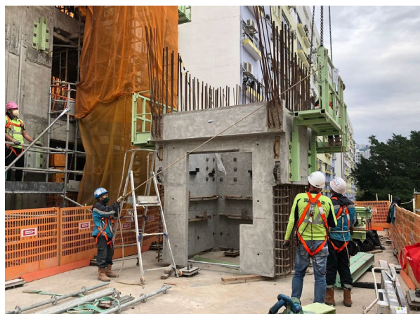
將臨時工作平台安裝 在MiC Lift core 上
