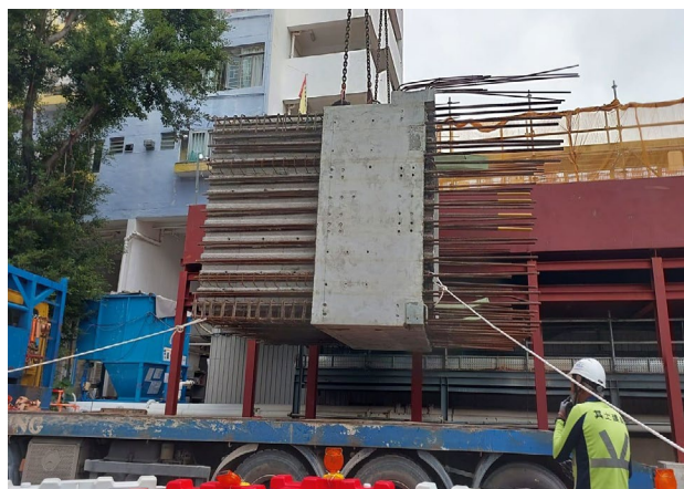
起卸區進行吊運3-3-3檢查
