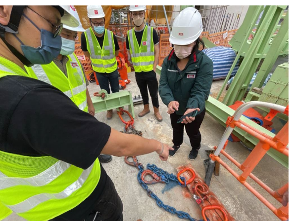
吊運前檢查所有吊具狀態
