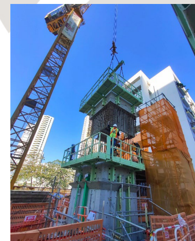
校準MiC Lift Core到 準確位置進行安裝
