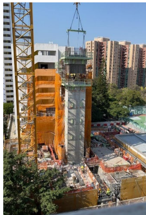
重覆步驟吊裝 所有MiC Lift Core
