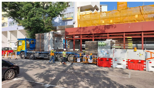
MiC Lift Core抵達起卸區
