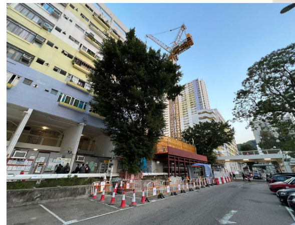
確保吊運起卸區圍封妥當 (吊裝當天早上)
