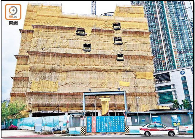
油麻地工地一電工 鋪設電纜時墮地 身亡
