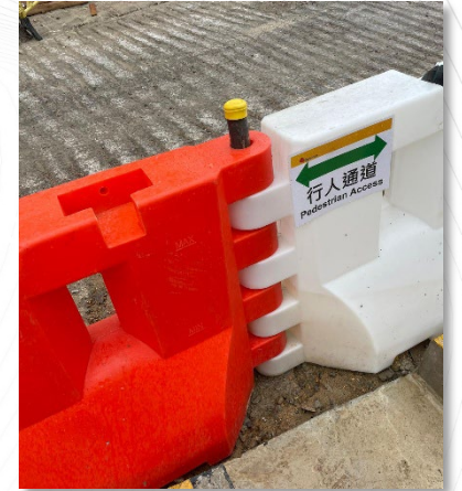
Install Metal Bar for Water Barriers on the Slope 在斜坡上的水碼安裝金屬桿
