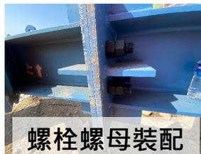
採用創新的**模塊化側向支撐系統 (M-ELS)**，工廠預製、現場組裝，以提高工作效率和安全性。
