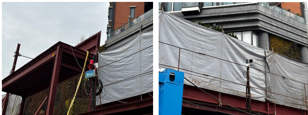
帶警示功能的智能攝像鏡頭，用於檢測安全帽和反光背心的使用情況 X 2
