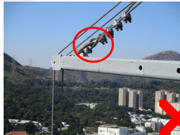
吊船工作平台違規使用U型纜索夾連接
