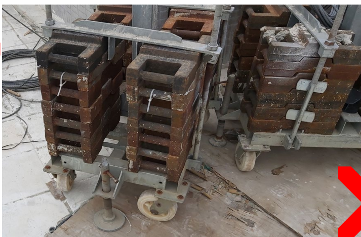
吊船衡重物總重量未有符合施工方案要求
