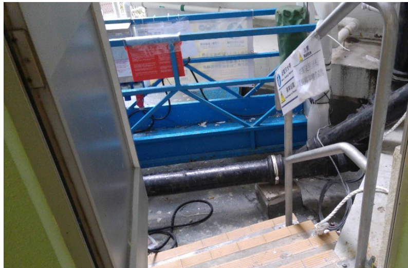
吊船提供安全進出通道
