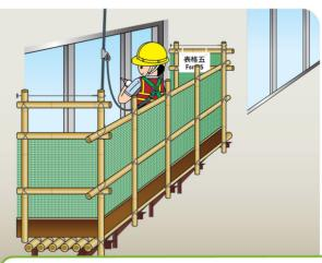
工人在搭建、改動、拆卸棚架或在吊棚上施工時,必須配戴全 身式安全吊帶,並把懸掛繩繫於穩固的繫穩裝置(例如羊眼圈)或 連接到獨立救生繩上的防墮裝置。
