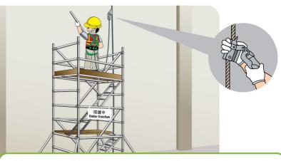
在搭建、更改、拆卸棚架、或設置安全工作平台或提供安全進出口 並不切實可行時,須配戴全身式安全吊帶,並繫於穩固的繫穩點或 獨立救生繩上。
