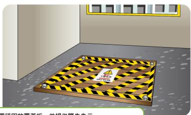
在樓面孔洞設置穩固的覆蓋板,並提供警告告示。
