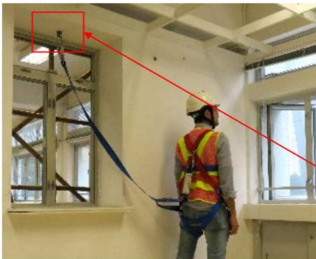
圖 7 - 工人使用有眼螺栓時的情況
