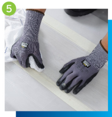
完工前檢查地板接駁位置平整度及清理地面多餘膠漿
