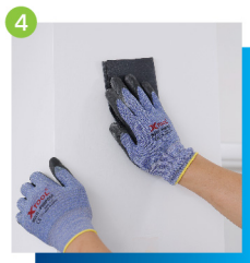
4 將漆灰面進行打磨處理
