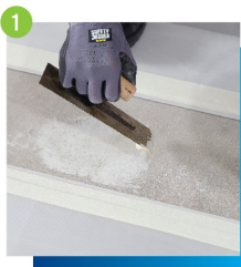
於接駁口位置進行物面處理及清潔，並使用混合填充物料整理凹凸不平地面
