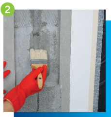
2 在接駁批盪收口位，塗刷黏合防水膠漿（需用工地批核的物料）
