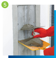
5 將混和好的水泥沙漿，按序批在接駁收口位置上（注意在物料指定要求時間內進行）
