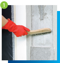
1 清潔混凝土表面灰塵
