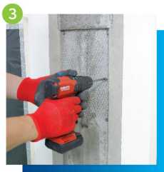
3 以不鏽鋼螺絲安裝批盪網（俗稱：雞仔網），螺絲定位間距不多於150mm
