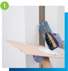
1 於接駁口位置進行物面處理及清潔，並使用紙帶灰批填漆灰
