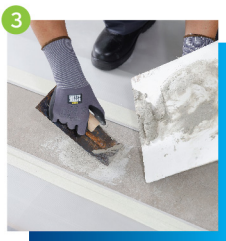
選擇水溶性地板膠漿並用有坑紋灰匙刮填膠漿
