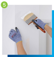
5 為整體牆身進行最後一層乳膠漆施工，並確保牆身漆面平整、順滑及髹漆色調一致
