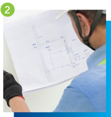
2 按批核管線圖紙進行開料及安排佈管
