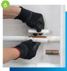
6 最後在焊接接駁口包裹「蝦殼」飾面
