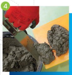
4 按工程批核要求，以指定防水膠漿及混和比例，製作批盪水泥沙漿
