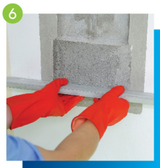
6 用壓尺盪平水泥沙漿，並確保沙漿壓實，填充飽滿、平整，最後進行飾面處理
