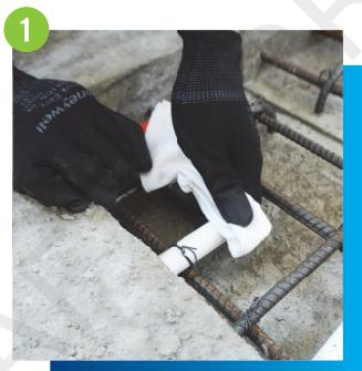
施工前需要清理套通接駁口的混凝土沙漿，並確保沒有異物阻塞在管道內
