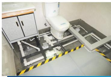
下沉式樓板設計廁所將大部分喉管藏於廁所室內底部及假天花之上，於外牆來去水接駁收口工序相對一般廁所設計較少
