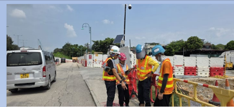
清晰交底 挖掘許可
