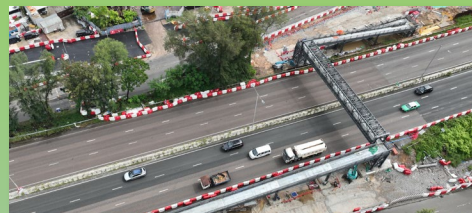
全封高速 順利裝橋
