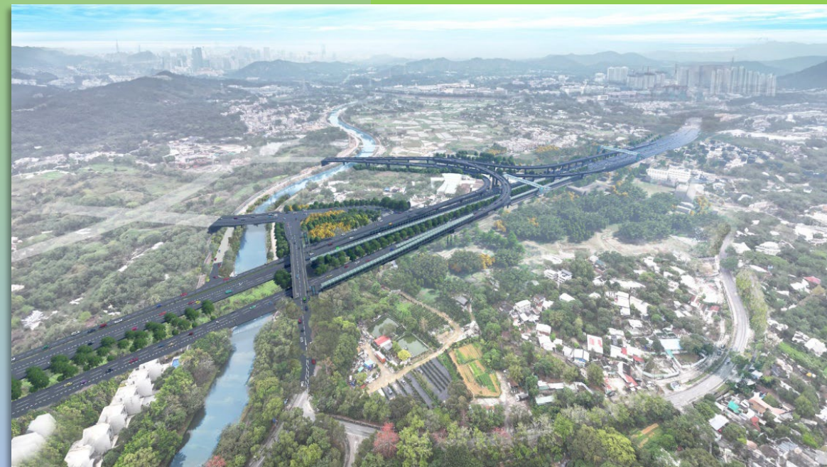
古洞北新發展區餘下工程-粉嶺公路(古洞段)改善 工程及相關工程
