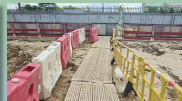
橋板臨時施工便道
