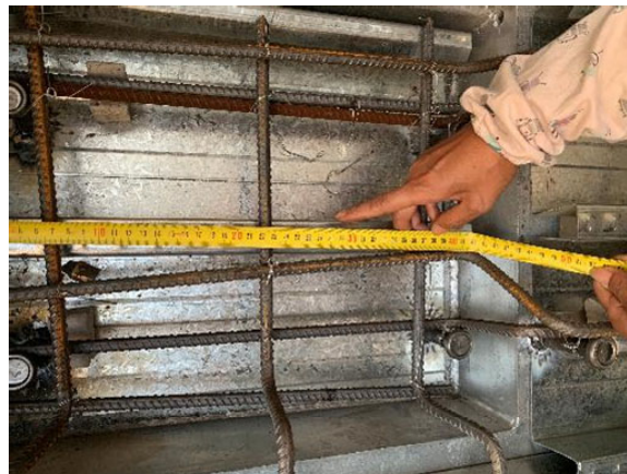
Rebar checking
