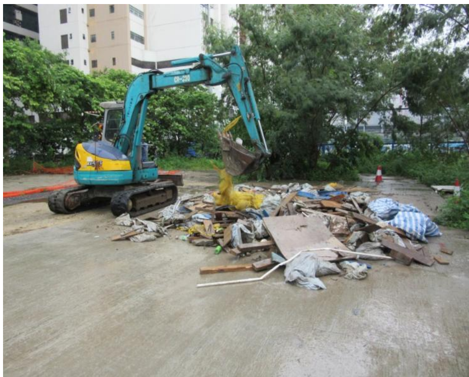
圖 4 使用鏟斗機分攤建築廢物
