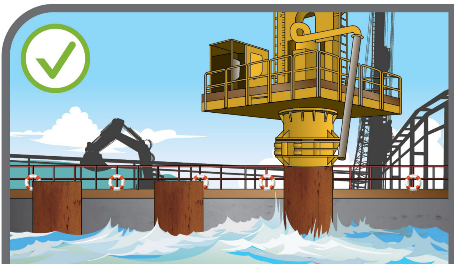
水上作業機械須設有適當的工作平台、護欄及底護板。
