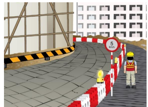
設置連續性圍欄，以分隔行車及行人通道
