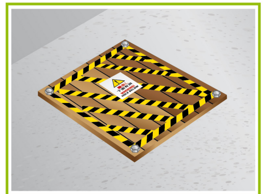
使用穩固覆蓋物及貼上警告告示。
