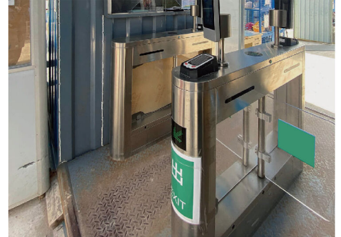
安裝入閘機連讀證裝置
