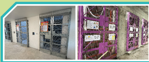
臨時鋼閘 / 鋼門
