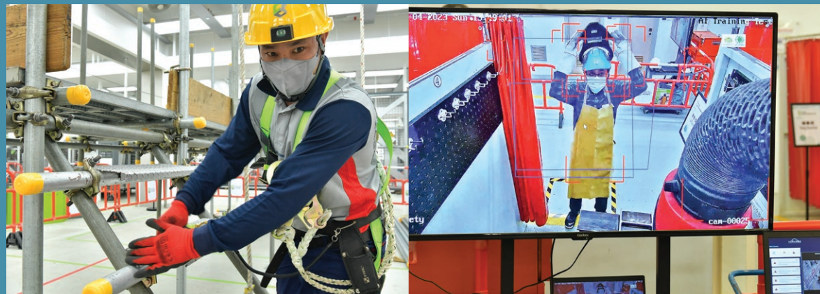
於比賽引入4S (Smart Site Safety System) 安全科技應用，例如金棚科比賽應用了智能安全帽、焊接科比賽加入了AI視頻監控等。
