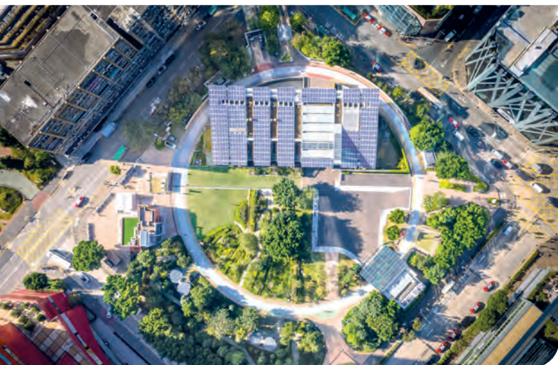
建造業零碳天地持續更新設施
