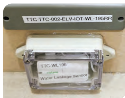
漏水傳感器(點型)
