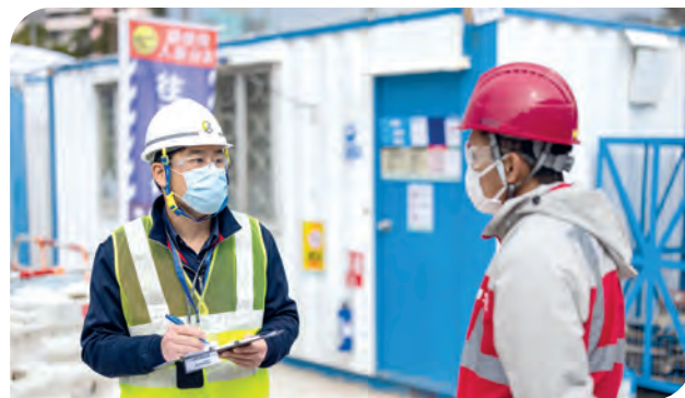
巡查及執法隊巡查建造工地
