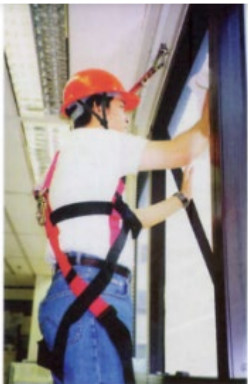
照片一：使用全身式吊帶及固定繫穩物進行抹窗工作
