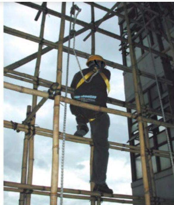
照片四：使用繩索夾頭及垂直獨立救生繩進行竹棚架搭建或拆卸工作
