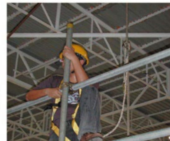
照片五：使用繩索夾頭及垂直獨立救生繩進行金屬架搭建或拆卸工作
