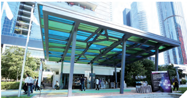
The Air Improvement Photovoltaic Glass Canopy at CIC – ZCP 建造業零碳天地內的「空氣淨化太陽能玻璃天幕」
