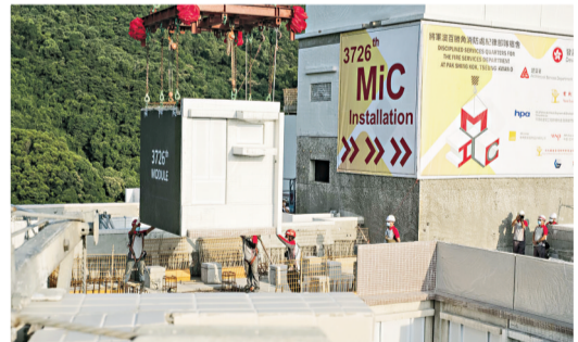
▲預製模組在生產過程中，已將大部分裝修、機電設備內置，減省後期漫長的裝修時間。
