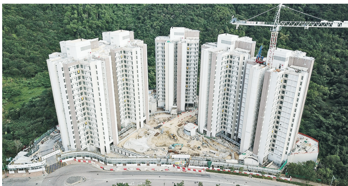
▲百勝角項目採用「五日循環建築法」，每五天興建一樓層，較傳統建築法提早四個月完工。
