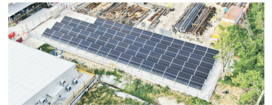
▲採用太陽能發電，為工程項目及整個社會減碳。
