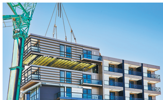
▲組裝合成建築法（MiC）能提升生產力，為建造業界員工營造舒適安全的工作環境，建造的樓宇在結構、質量和安全性都非常穩定。
