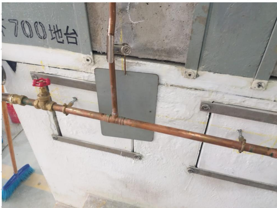
銅錫叉焊接保護
